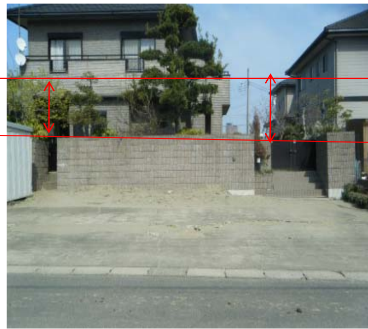
沈下した家(ブロック塀)
