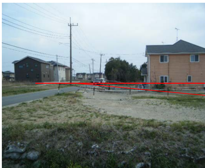
大きく沈下した家
