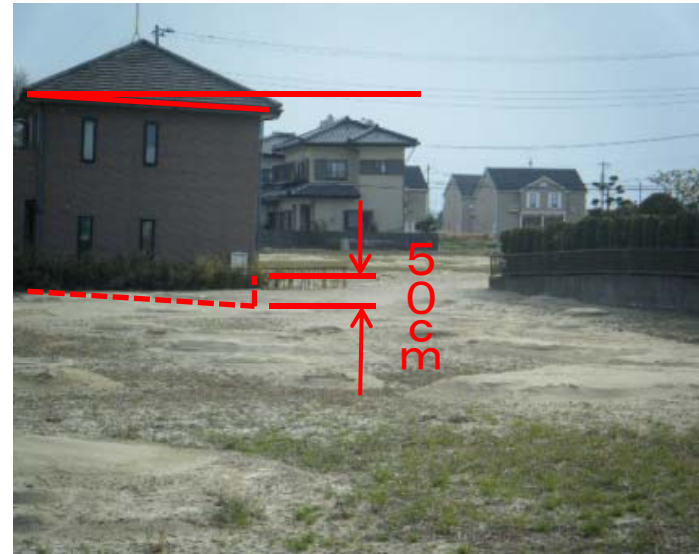
家が沈下し噴砂で埋まる
