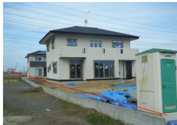
大きく沈下したブロック塀
